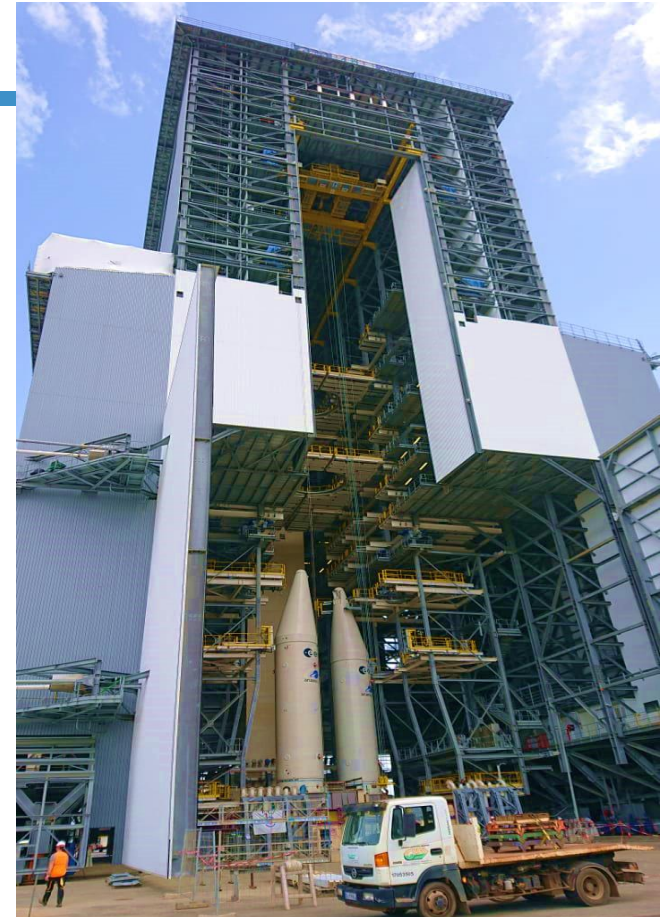
Технологическая сборка блоков Ariane-6 в МБО
