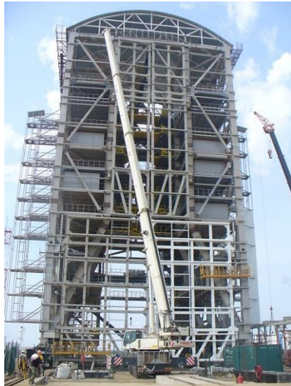
Монтаж ферменной конструкции МБО
