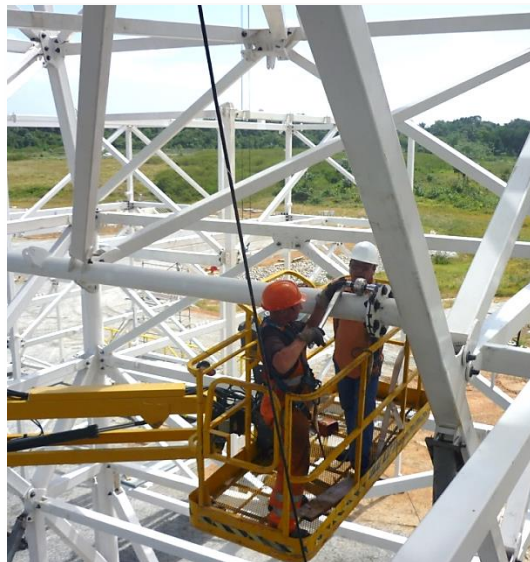
Сборка типовых узлов МБО
