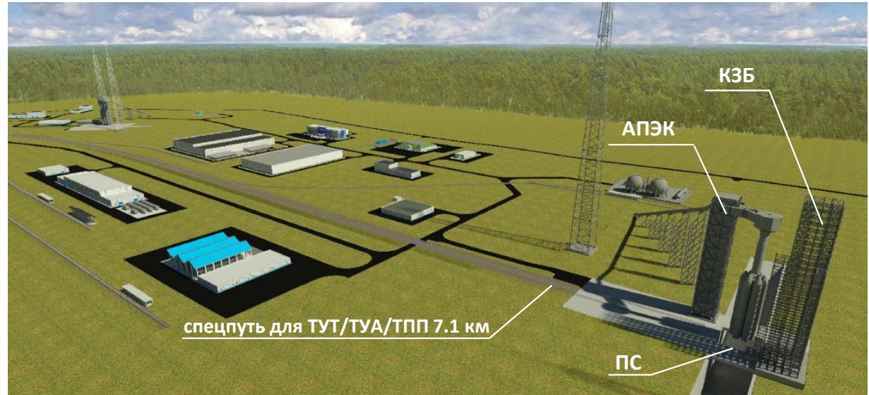
Технический облик УСК для горизонтальной сборки РКН СТК с КЗБ и АПЭК
