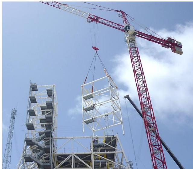
МБО смонтирована из модулей весом до 11 т
